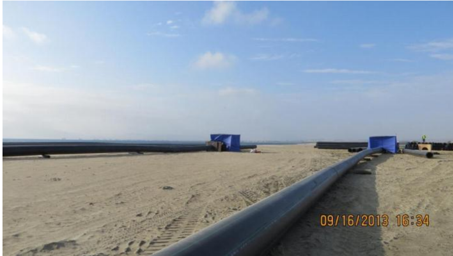
Avances de las operaciones de termofusión.
