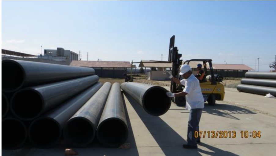
Recepción de las tuberías.
