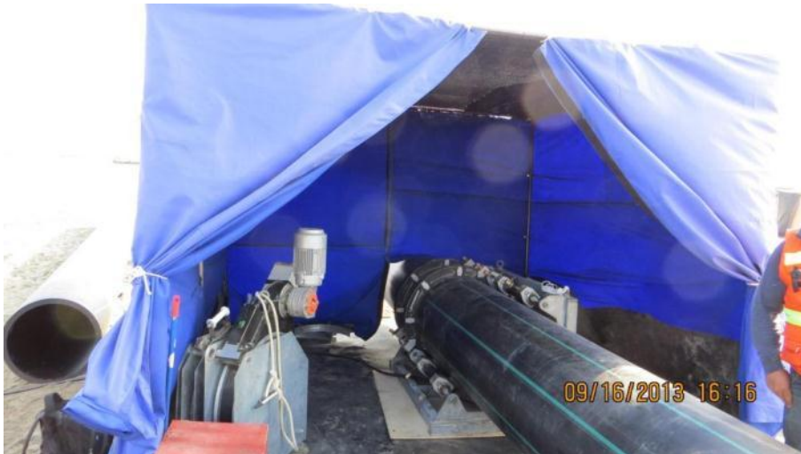
Operación de termofusión de los tramos de tubería.
